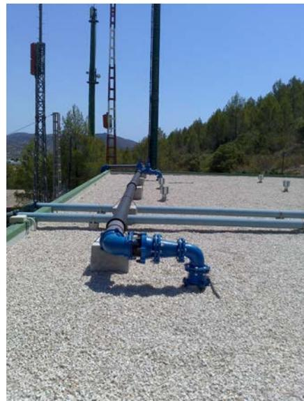
**Tubería fundición dúctil aérea. Instalación tubo con válvulas en cubierta depósito**
