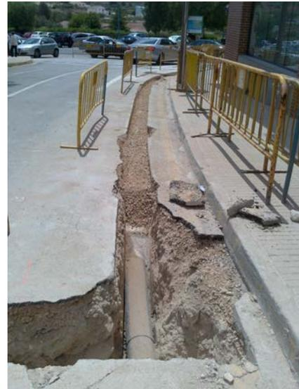
**Tubería polietileno alta densidad y relleno de zanja con zahorras artificiales**
