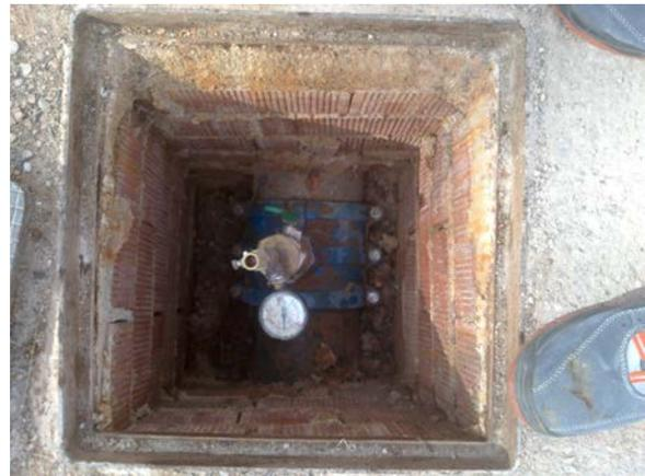
**Protección del tubo con hormigón. Ventosa instalada en arqueta**
