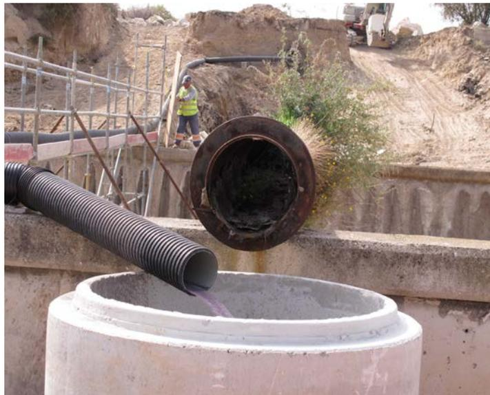
**Vista de la conducción obsoleta y de la provisional tendida sobre andamio para evacuar las aguas residuales, una vez saneado el terreno receptor del vertido**
