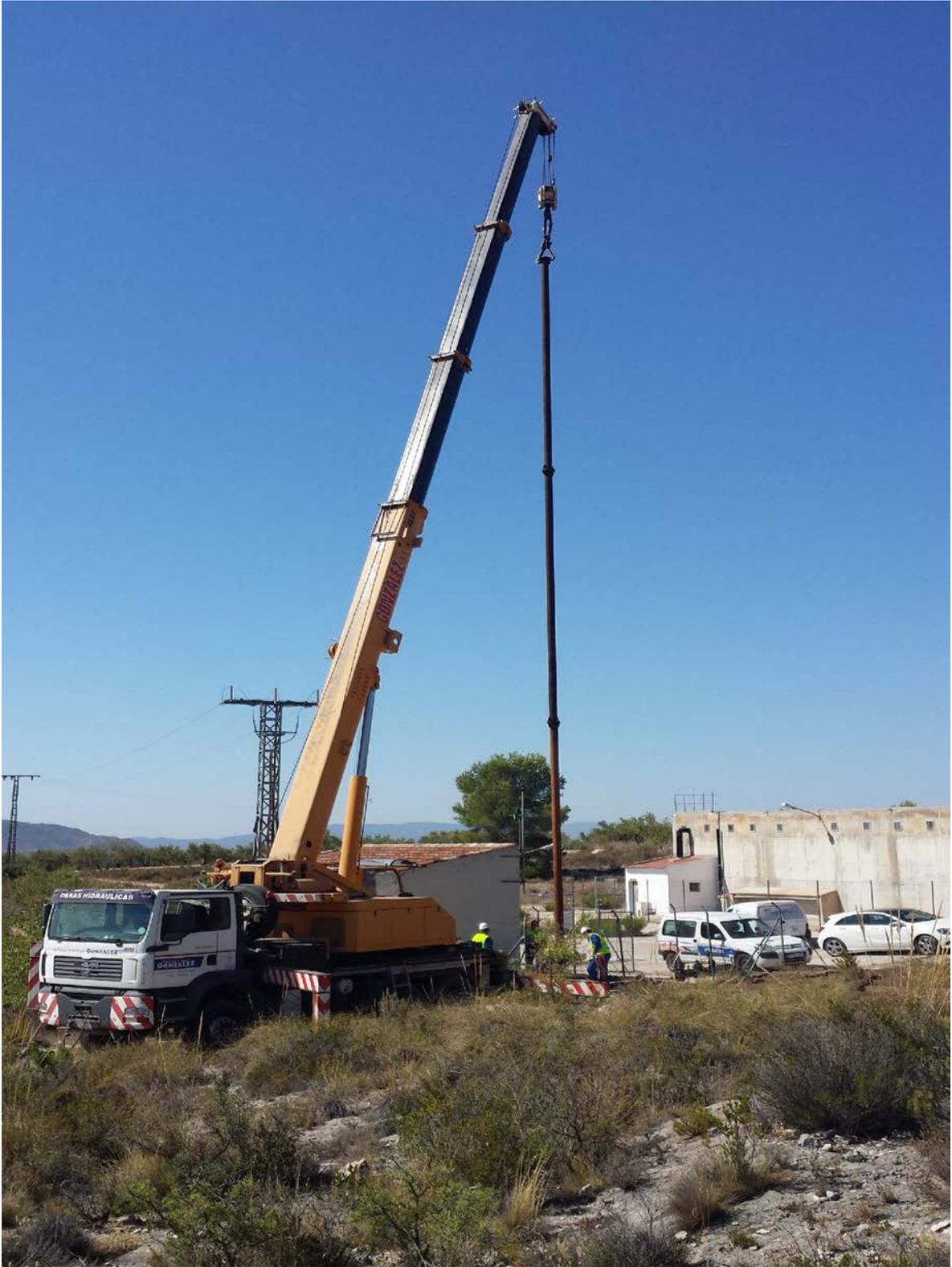
**Instalación de nueva electrobomba en el pozo Solana a 310 m. de profundidad**
