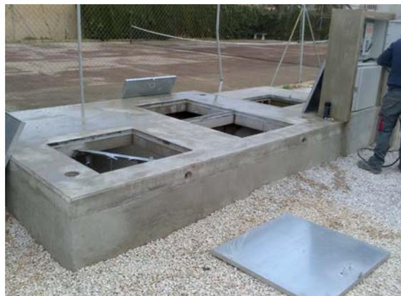
**Cámara de llaves: valvulería y piezas especial, y estructura de hormigón de la estación de bombeo de aguas residuales**
