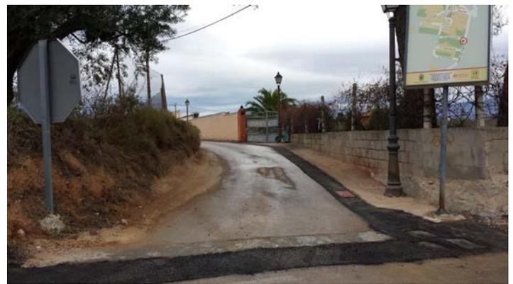
**Tubería de polietileno instalada en zanja - Reposición de aglomerado asfáltico en calzada**
