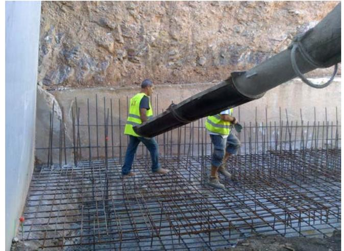
**Cartel de obras y hormigonado de la cimentación del muro de contención**
