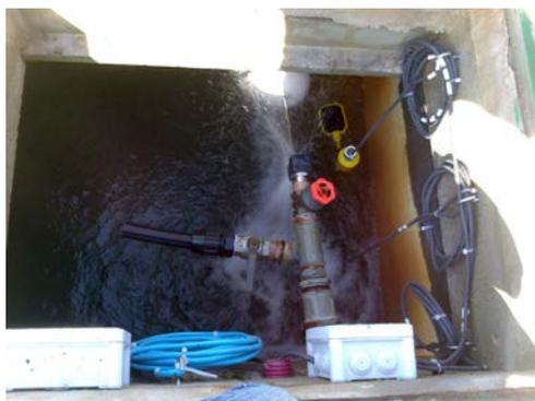
**Contador, sondas de nivel, sistema de válvulas by-pass y sistema de dosificación de cloro en depósito**
