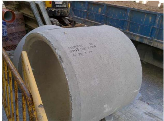
**Cartel de obras y anillo prefabricado de hormigón para pozo de registro de saneamiento**
