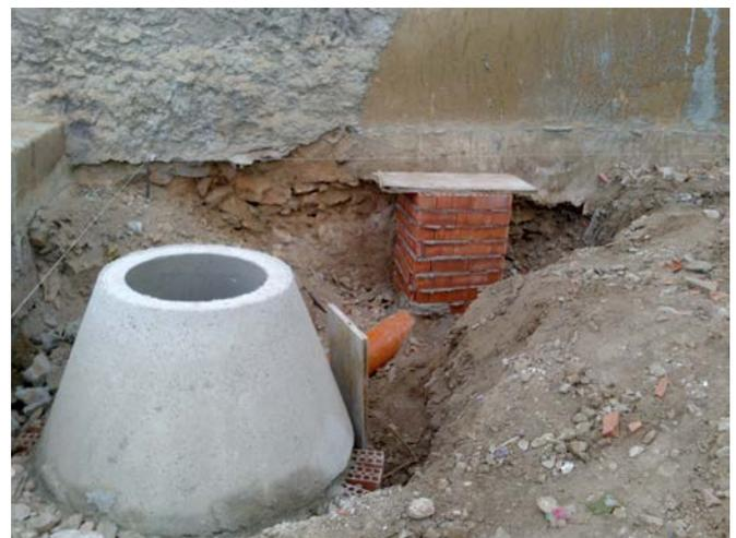
**Tubería de abastecimiento de fundición dúctil y red de saneamiento con pozo de registro**
