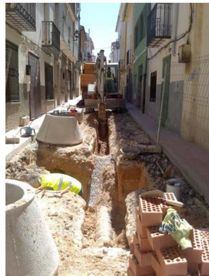
**Cartel de obra y zanja para instalación de tubo de saneamiento y pozo de registro prefabricado**
