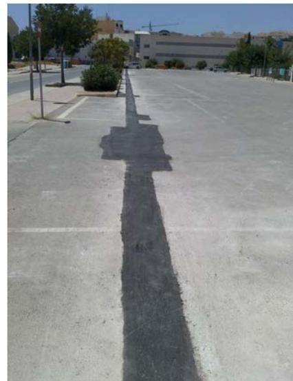
**Zanja rellena con zahorras compactadas y reposición de zanja con aglomerado asfáltico**
