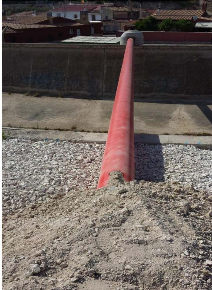
**Nueva conducción terminada, con vertido al pozo de resalto de la orilla opuesta del río Vinalopó**
