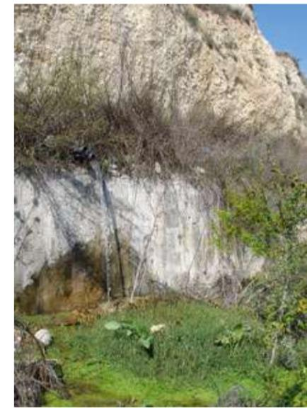
Aliviadero, que descarga al río Serpis, de una galería de captación para abastecimiento a L'Alquería. En la vista frontal se aprecia que la salida se produce por el contacto entre los materiales impermeables del Tap y los cuaternarios de las terrazas fluviales suprayacentes.
